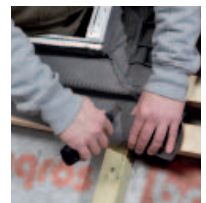
Az alátétfólia pontosan passzol az ablaknyílásra
