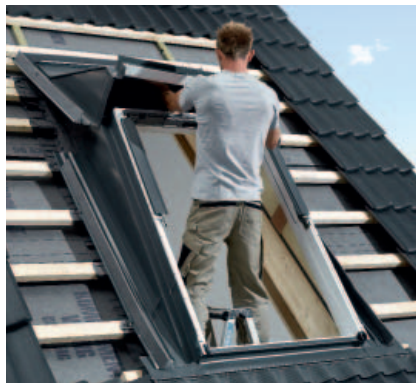
5. Végül a külső takarólemezek rögzítése és az ablakszárny behelyezése.
