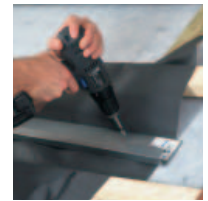
Az öntartó vízlevezető csatorna elvezeti a vizet az ablaktól
