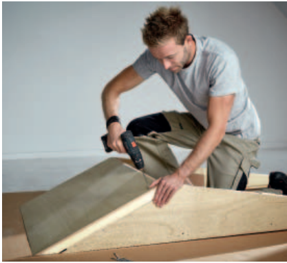
1. A csomagolásban található szigetelő elemek összeszerelése.
