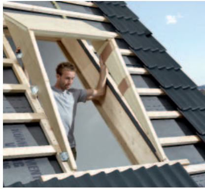
2. A szigetelőelemeknek az előkészített tetőnyílásba fektetése és rögzítése.
