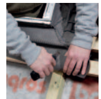
Az alátétfólia pontosan passzol az ablaknyílásra
