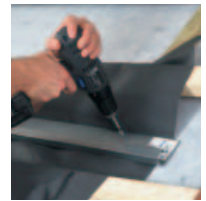
Az öntartó vízelvezető csatorna elvezeti a vizet az ablaktól
