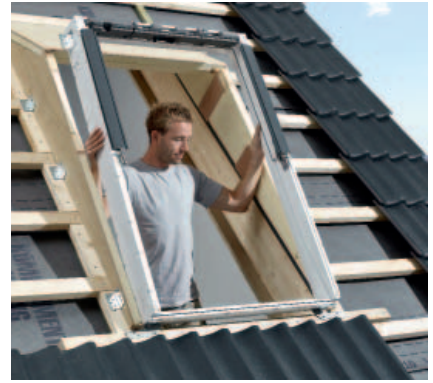
3. Az ablakoknak a szigetelőelemekre fektetése és lecsavarozása.
