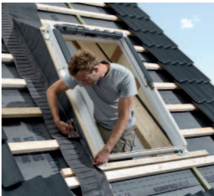
4. A vízzáró csatlakozás biztosítása érdekében a csomagban található BFX alátétfólia felhelyezése.
